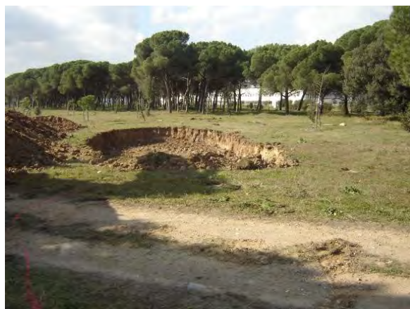
Construcció de la bassa d'amfibis
